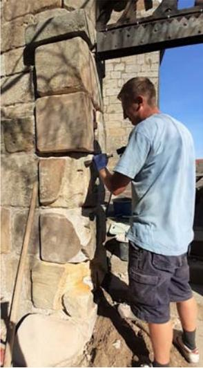
*Erster Schritt ist die Entfernung allen schadhaf-ten Materials.*
