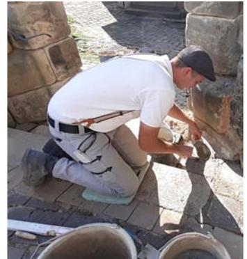
*Nach der Reinigung muss alles frisch verfugt werden.*
