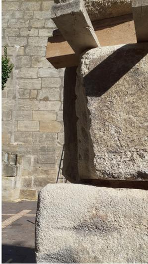
bei den Strebepfeilern im Gässchen am Roten Haus waren die Fugen teilweise 1,70 Meter tief und da war kein Mörtel mehr. Da kann man durchaus froh sein, dass nichts passiert ist. Wir dokumentieren ja alle Arbeiten und da kann man sagen: es sah schon übel aus. Wenn sie jetzt fertig ist, ist die Mauer wieder in einem guten statischen Zustand.
